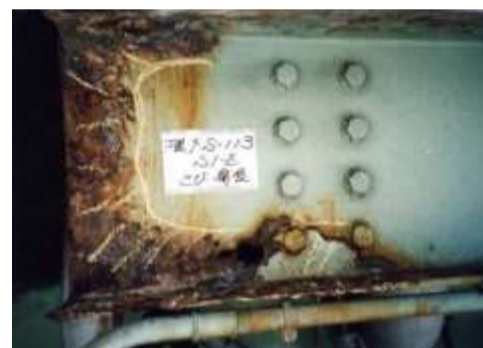
漏水により鋼桁端部の塗装が劣化し、鋼材が広範囲に腐食
