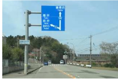
④国道305号（石川県大聖寺土木管内）
