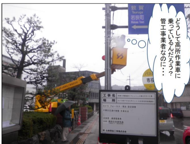
特殊で前提知識を要する施工
