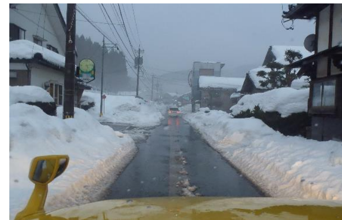
主要地方道 福井大森河野線 (越前市白山)
