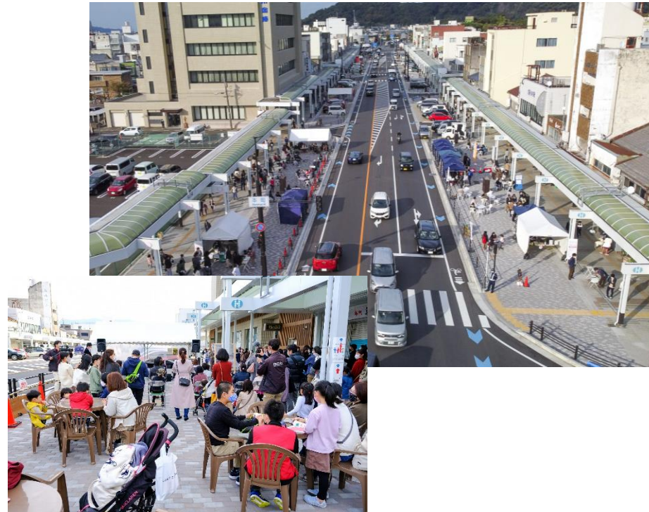
国道8号 (敦賀市元町交差点～白銀交差点)
