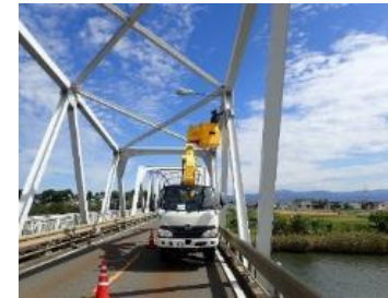
橋梁の定期点検
