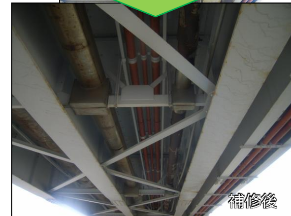
鋼材の腐食が進行しないよう塗装を塗り替え
