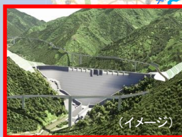
足羽川ダム建設(国)
