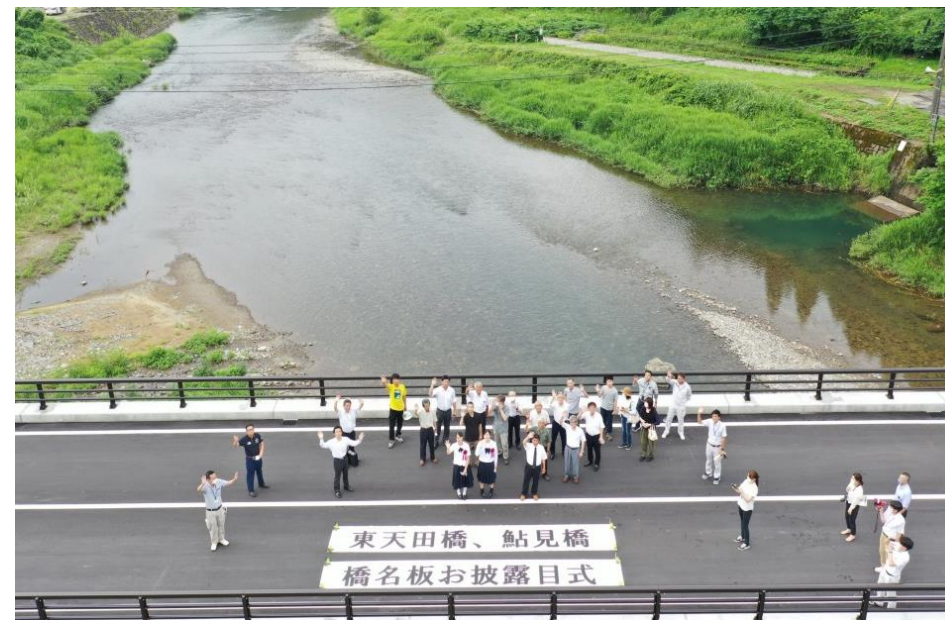
完成した鮎見橋で記念撮影
